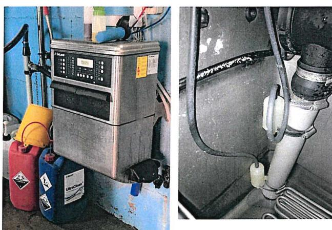
Figures 4: Résidus d'un obturateur de trayon contenant du bismuth dans un automate de lavage.
